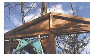
⑤ 表壁を取付け
