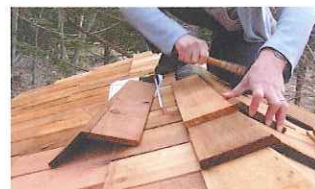
⑦ 棟キャップを葺く
