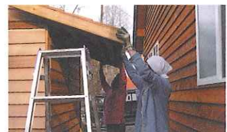
⑥ 屋根パネルを載せる
